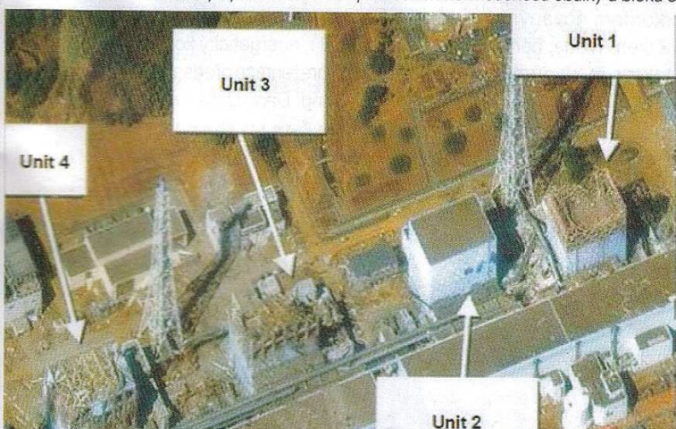
▼ Obr. 5. Následky výbuchů vodíku s porušením hermetičnosti obálky u bloku 3
