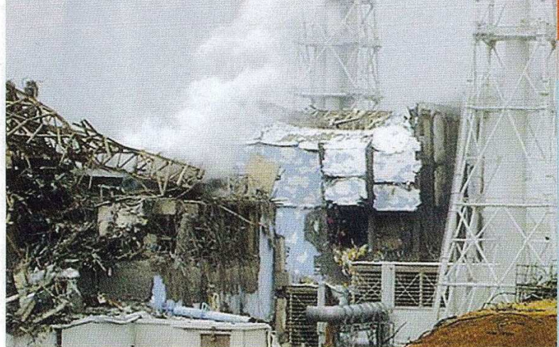
▲ Obr. 6. Následky výbuchů vodíku s porušením hermetičnosti obálky u bloku 3
